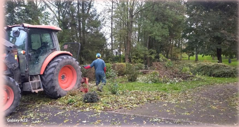
Travaux d'entretien de la Suippe, abattages des arbres menaçant.
